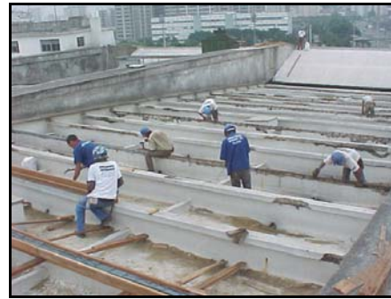
Foto 8: Execução de fôrmas para recomposição do concreto.
