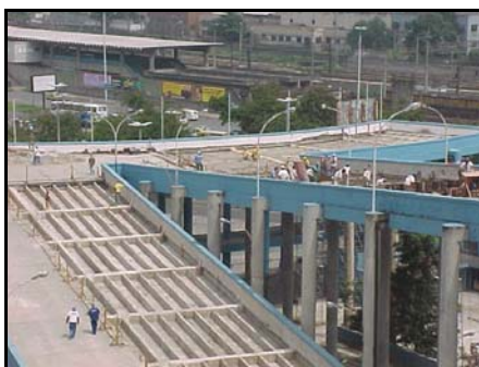
Foto 9: Vista geral da recuperação das rampas monumentais.
