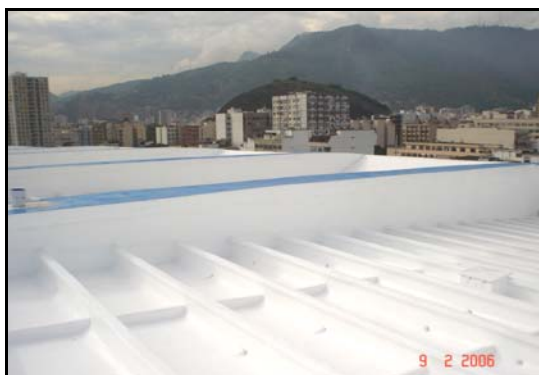
Foto 17: Proteção das estruturas da cobertura por meio de sistemas de impermeabilização.
