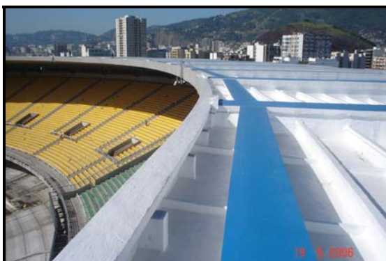
Foto 18: Proteção das estruturas da cobertura, após a conclusão da impermeabilização.
