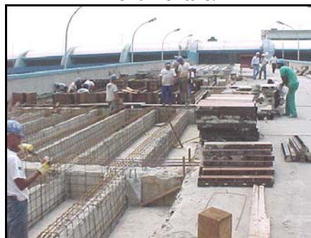
Foto 11: Montagem da armadura de reforço em vigamento de apoio, seguido de instalação de fôrmas.
