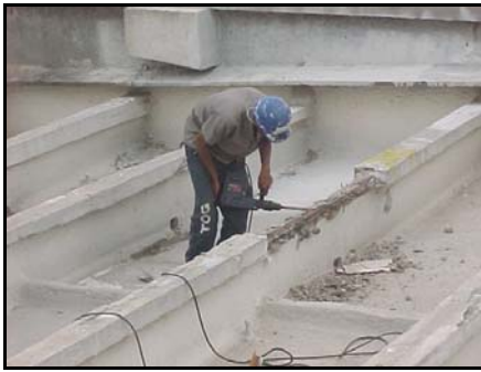
Foto 7: Corte do concreto danificado em mesa de compressão de viga.
