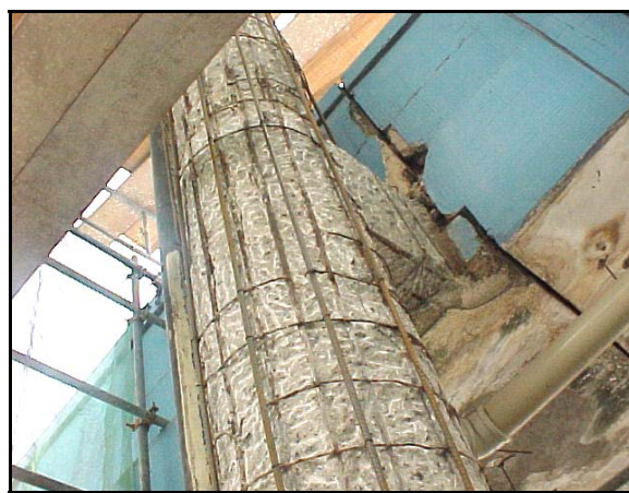
Foto 16: Instalação de armadura adicional de recuperação e reforço em pilares de apoio das rampas monumentais.
