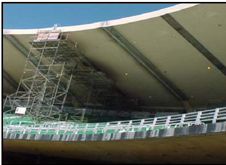
Foto 5: Recuperação do “balanços dos gigantes”, sob a cobertura.
