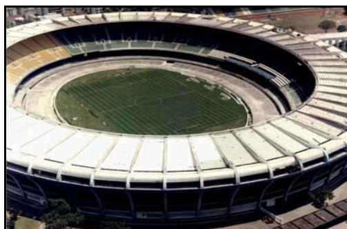
Foto 2: Vista da cobertura do estádio durante a obra de recuperação em 2000.
