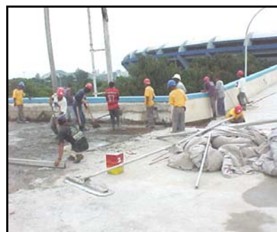
Foto 14: Lançamento de concreto referente às lajes superiores das rampas monumentais de acesso ao estádio.
