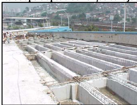
Foto 12: Procedimentos de cura do concreto, após o reforço das vigas de apoio das rampas monumentais.
