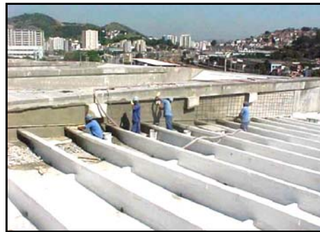
Foto 6: Recuperação do “balanços dos gigantes”, sobre a cobertura.
