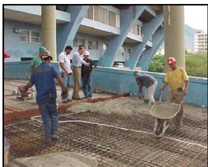
Foto 13: Supervisão dos serviços de concretagem das lajes superiores das rampas monumentais.
