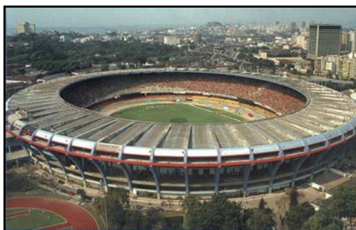
Foto 1: Vista geral do Maracanã antes dos serviços de recuperação iniciados em 1999.
