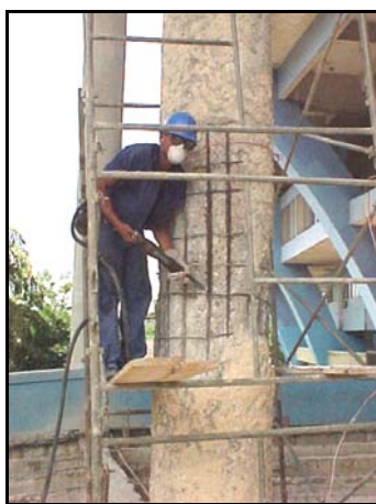
Foto 15: Vista parcial de pilar de apoio das rampas monumentais, durante recuperação e reforço.
