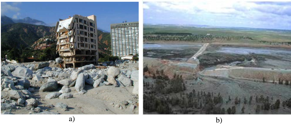
Figura 1.2. a) Flujo de detritos, Vargas, Venezuela 1999, foto: Facultad de Ing. Forestal-Universidad de los Andes. b) Falla de la presa para residuos de metales pesados en Aznalcóllar, España 1998, foto: http://www.wise-uranium.org .
