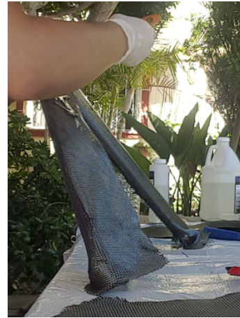
Figura 45. Aplicación de resina epoxica sobre fibra de carbono con brocha.
