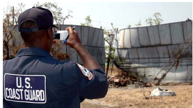
Figura 14b: Bass Enterprises North. Ponte a la Hache, Louisiana. Detalle de los tanques arrastrados por el agua. (Fotografía de USCG).
