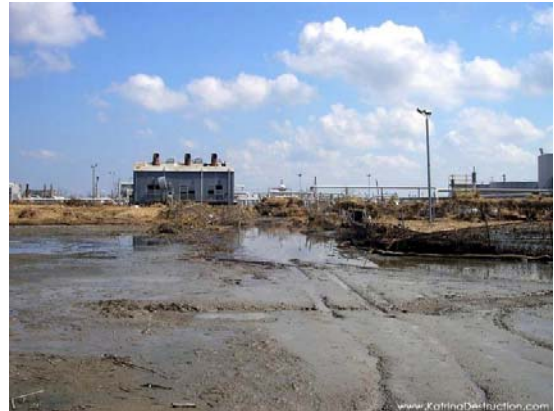
Figura 11b: Planta Dynergy, Venice, Louisiana. Vista de la zona inundada, con tres tanques sobre la derecha de la imagen. (Fotografía de USCG).
