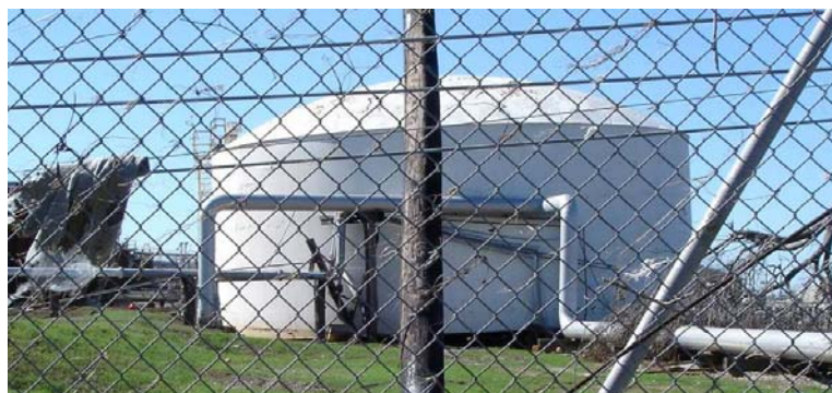
Figura 6: Tanque desplazado por la inundación en la planta de Freeport, Port Sulphur, Louisiana. (Fotografía de los autores, noviembre 17).
