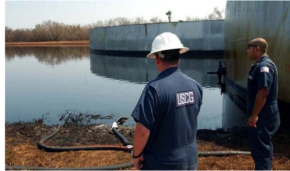
Figura 13b: Bass Enterprises, Cox Bay, Louisiana. Detalle de daños en los dos tanques grandes que fueron arrastrados. (Fotografía de USCG).
