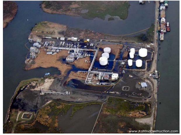
Figura 10b: Vista aérea de la planta Dynergy, Venice, Louisiana. (Fotografía de USCG).
