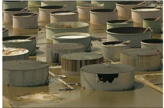
Figura 19b: Planta inundada de Exxon Mobil y Petróleos de Venezuela, en Chalmette, Louisiana.
