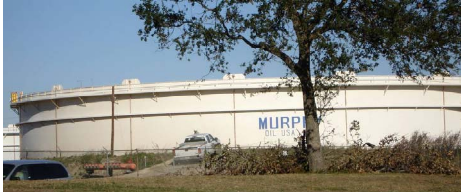
Figura 18a: Uno de los tanques mayores en el sector norte de Murphy Meraux Refinery. El tanque tiene un rigidizador horizontal para prevenir pandeo. (Fotografía de los autores, noviembre 16).
