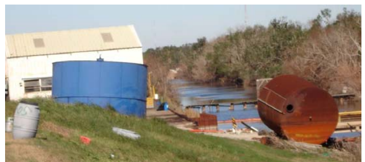
Figura 9b: Pequeños tanques arrastrados por la inundación debida a Katrina. Se trata de un lugar diferente del de la Figura 12.a. (Fotografía de los autores, noviembre 17).
