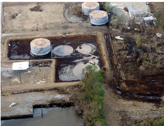
Figura 14a: Bass Enterprises North, Ponte a la Hache, Louisiana. Los tanques fueron arrastrados por el agua. Se descargaron cerca de 461,000 galones de combustible. (Fotografía de USCG).
