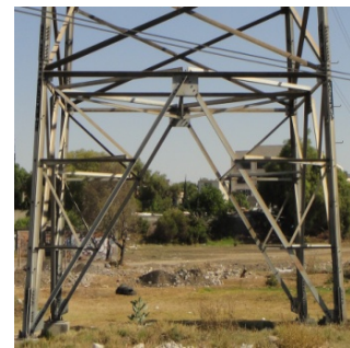
d) Vista de la base
