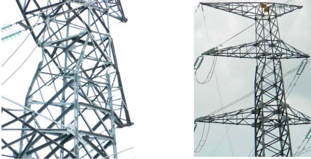
Figura 12: Daño relacionado con el cambio de sección en torres sometidas a viento intenso.
