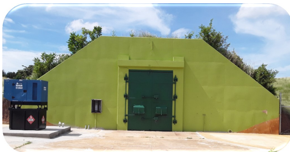
Figura 1B: Estado del “Bunker” seleccionado avanzada la rehabilitación (24/Oct/19).
