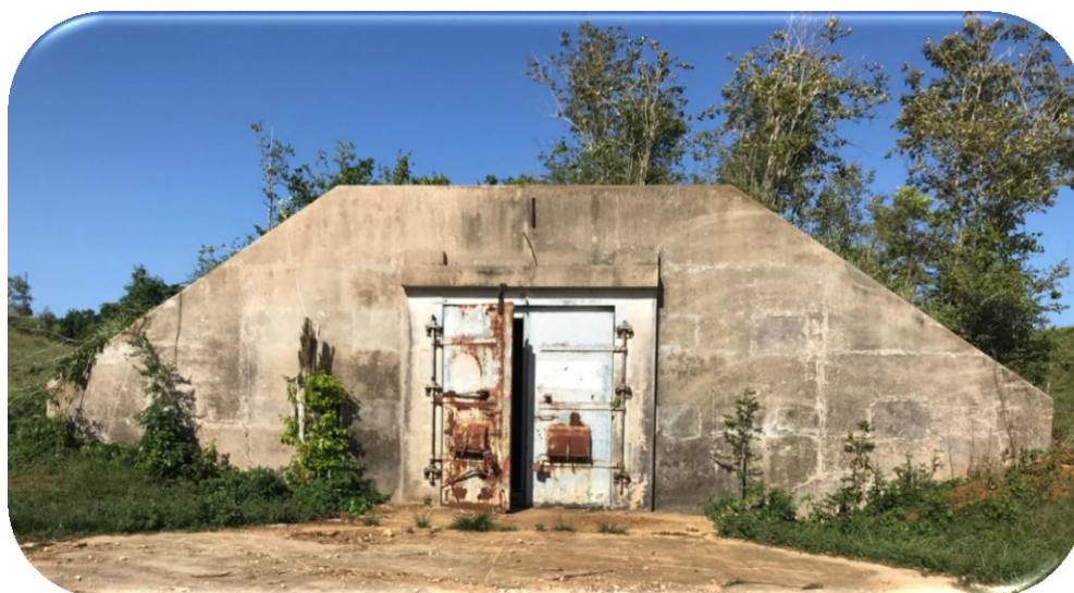
Figura 1A: “Bunker” seleccionado para albergar el Centro de Datos Secundario del PRSMP (13/Jul/18).
