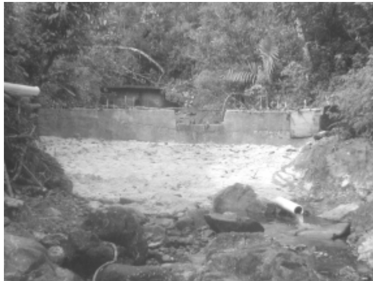
Figura 3: Vista Aguas Arriba de la Nueva Toma de Agua
