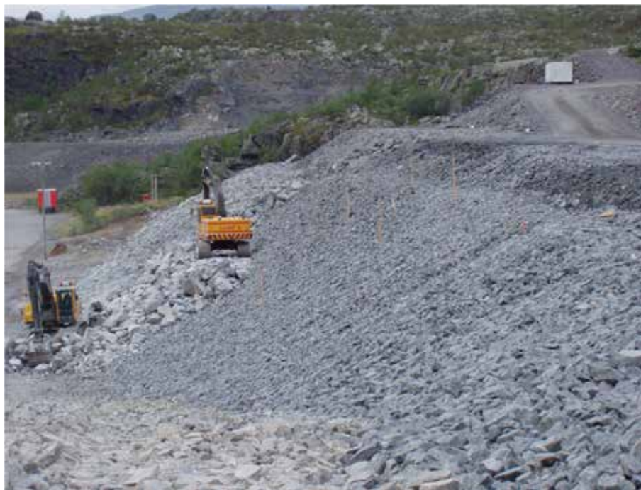
Foto 4. Construcci3n de la protecci3n en repi  de la presa de Suorva (Fuente: Nilsson 2004)
