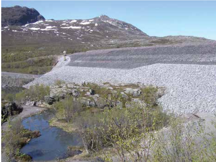
Foto 3. Vista desde aguas abajo de la protección de la presa de Sourva (Fuente: Nilsson 2004)
