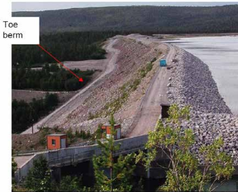
Foto 5. Repié de protección en la presa de Seitevare (Fuente: Nilsson 2009).
