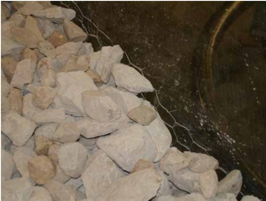
Foto 15. Detalle de la malla metálica instalada junto al cristal del canal.
