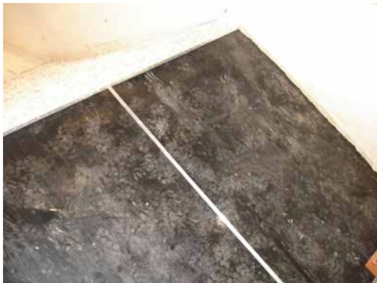
Foto 16. Pantalla impermeable de aguas arriba
