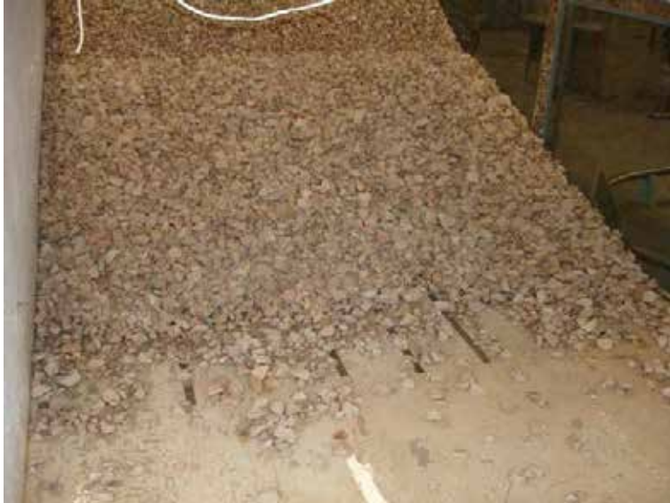
Foto 18. Ejemplo de daño de nivel 1. Caso H_b^* = 0,6 ; N_b = 3,0 .
