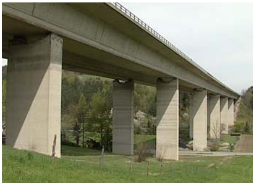
Figura 1: Vista longitudinal de las estructuras gemelas del puente Warth.
